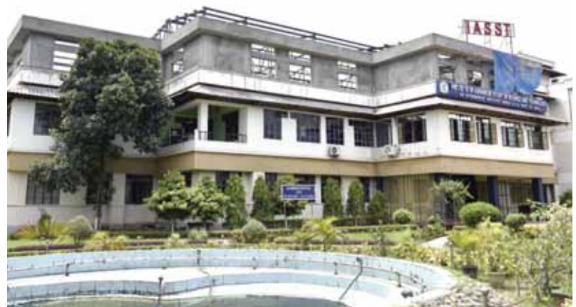
पुस्तकालय भवन में चल रहे लंब विस्तार कार्य का दृश्य।
